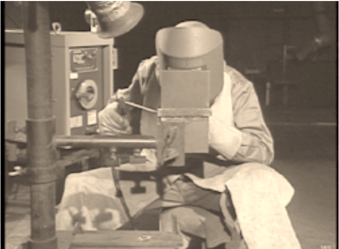
写真44：横向溶接の作業姿勢
