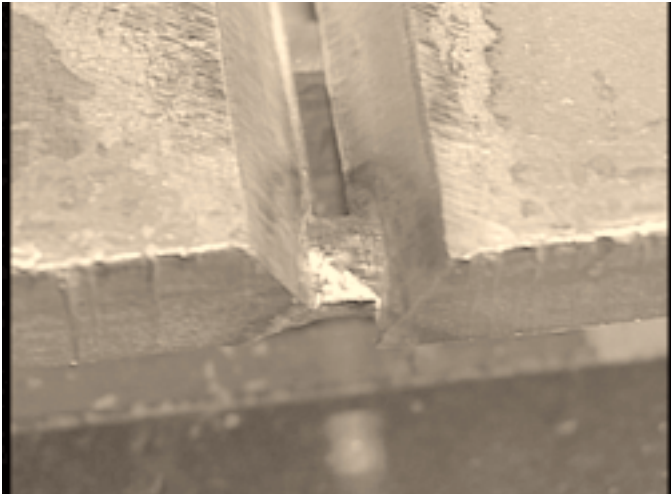
写真60：タック溶接ビード外観
