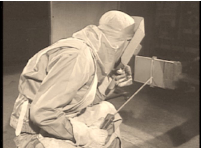
写真28：立向溶接の作業姿勢
