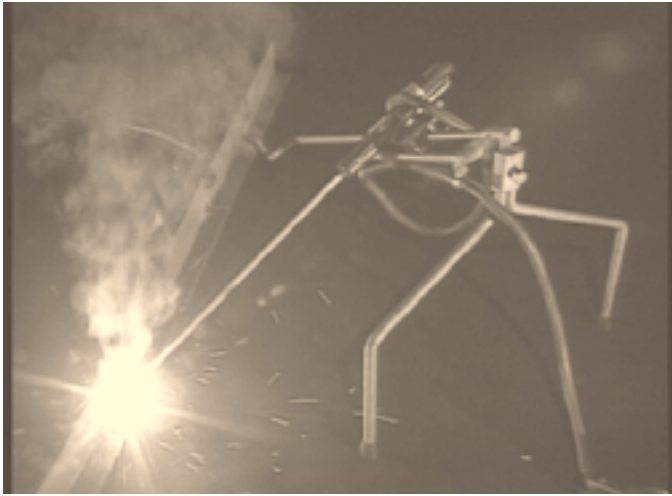
写真73：グラビティ溶接機の水平すみ肉溶接への適用状況
