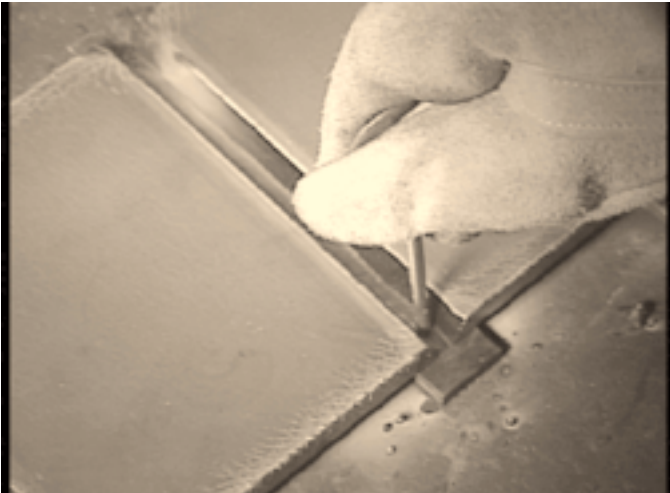
写真16：隙間ゲージによるルート間隔の調整
