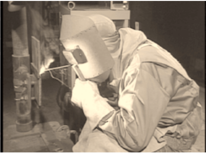
写真45：横向溶接1層目の溶接棒保持角度
