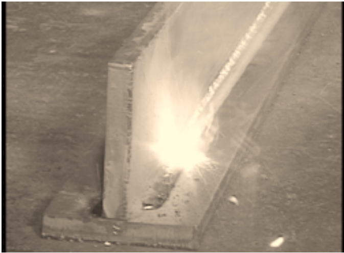
写真74：2層1パス目の溶融池外観
